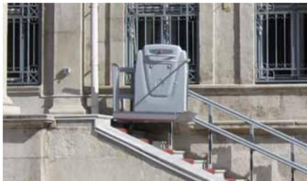
Para las instalaciones al aire libre, ofrecemos la opción de la cubierta protectora impermeable, que se puede utilizar cuando la plataforma no está en uso.
